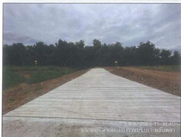
ฉ) การซ่อมแซมสภาพผิวจราจรที่ได้รับผลกระทบจากกิจกรรมก่อสร้าง
