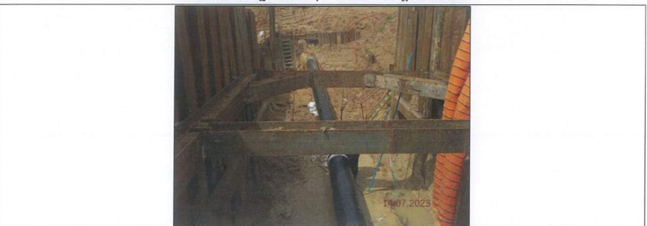
รูปที่ 2-8 การติดตั้ง Sheet Pile ในพื้นที่ที่มีความเสี่ยงด้านดินถล่ม
