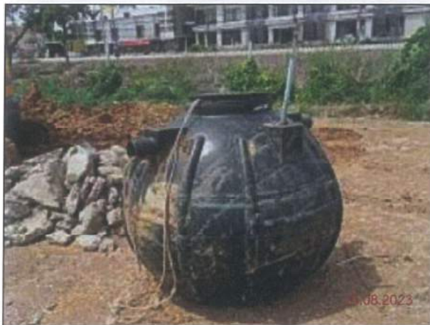
ข) การรื้อถอนถังบำบัดน้ำเสียสำเร็จรูป
