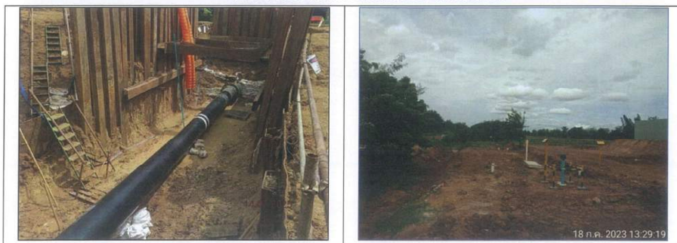
รูปที่ 2-2 การกลบท่อตันที่ภายหลังการวางท่อแล้วเสร็จ
