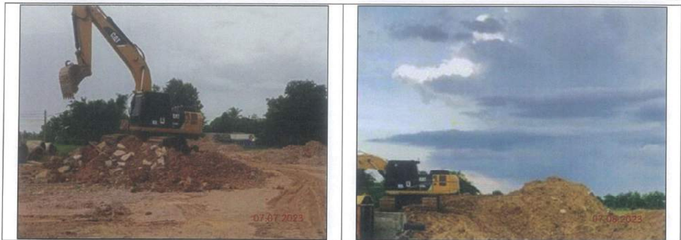
รูปที่ 2-13 การกองดินให้ห่างจากแหล่งน้ำ
