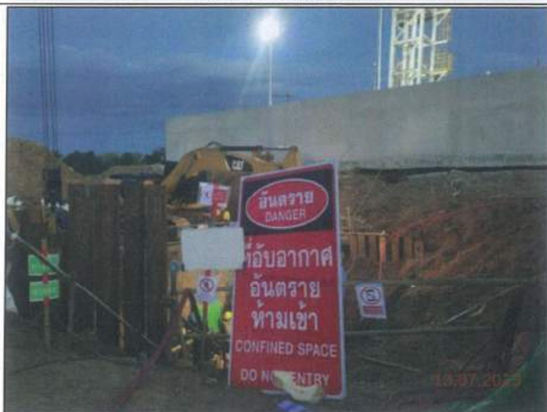
อุปกรณ์ป้องกันการตกหลุม และแสงสว่างและไฟกระพริบเตือนในเวลากลางคืน
