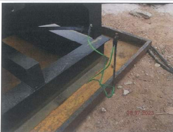
รูปที่ 2-17 การจัดเตรียมถาดเก็บรองรับน้ำมัน และวัสดุดูดซับ
