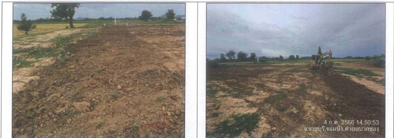
รูปที่ 2-9 การทำพูนดิน (Crown) บริเวณพื้นที่หลังท่อ
